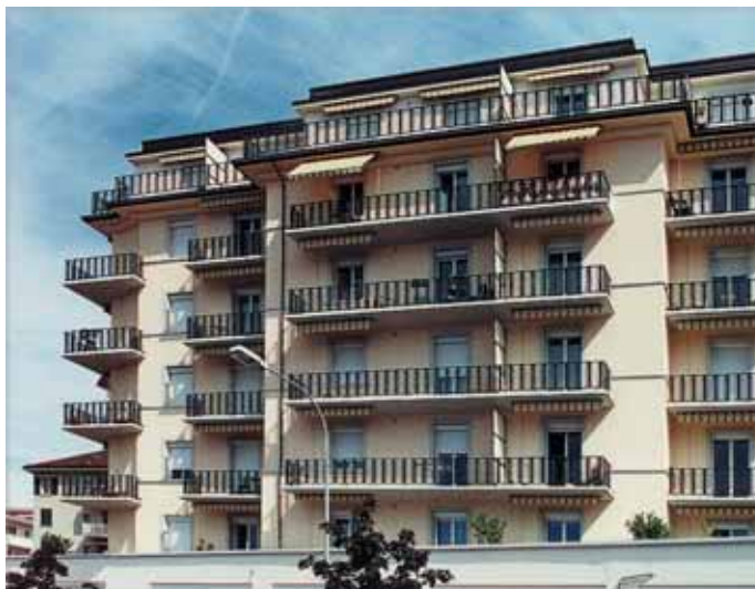
Détail de la façade Sud
