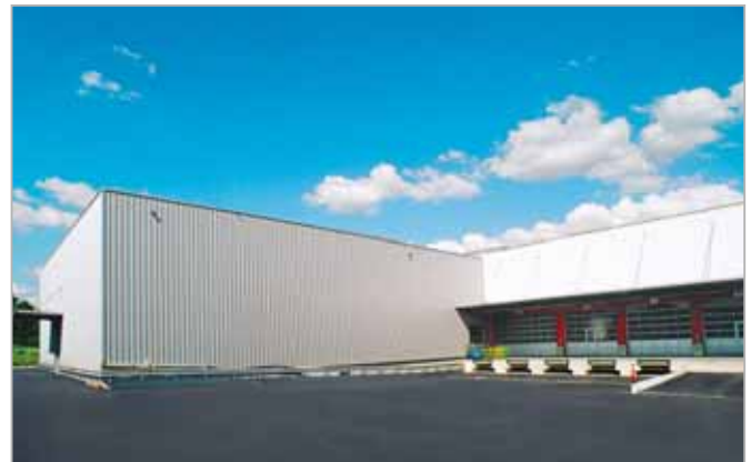
Halle "A" et quais
