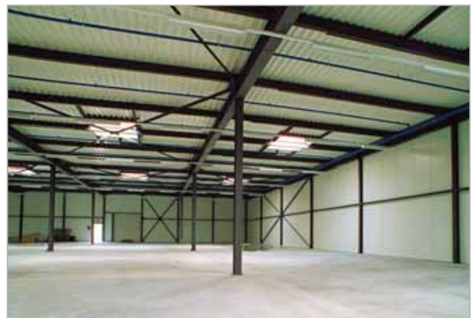
Dépôt aux surfaces généreuses
